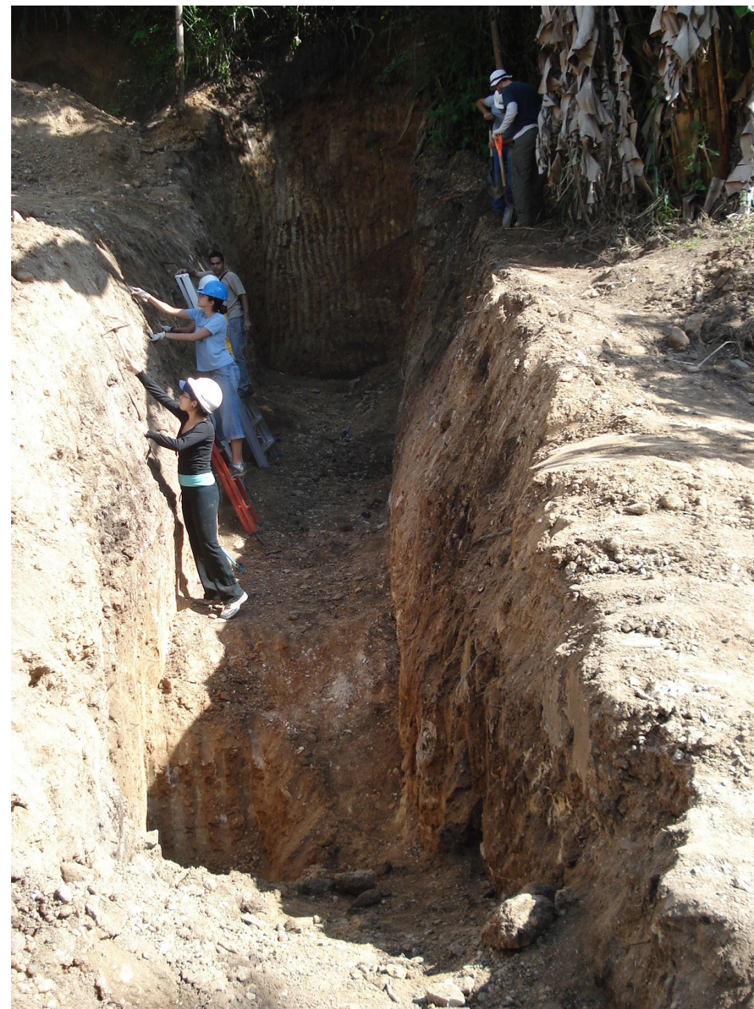
Figura 6. Limpieza de las paredes de la excavación, previo al levantamiento geológico de las mismas.
